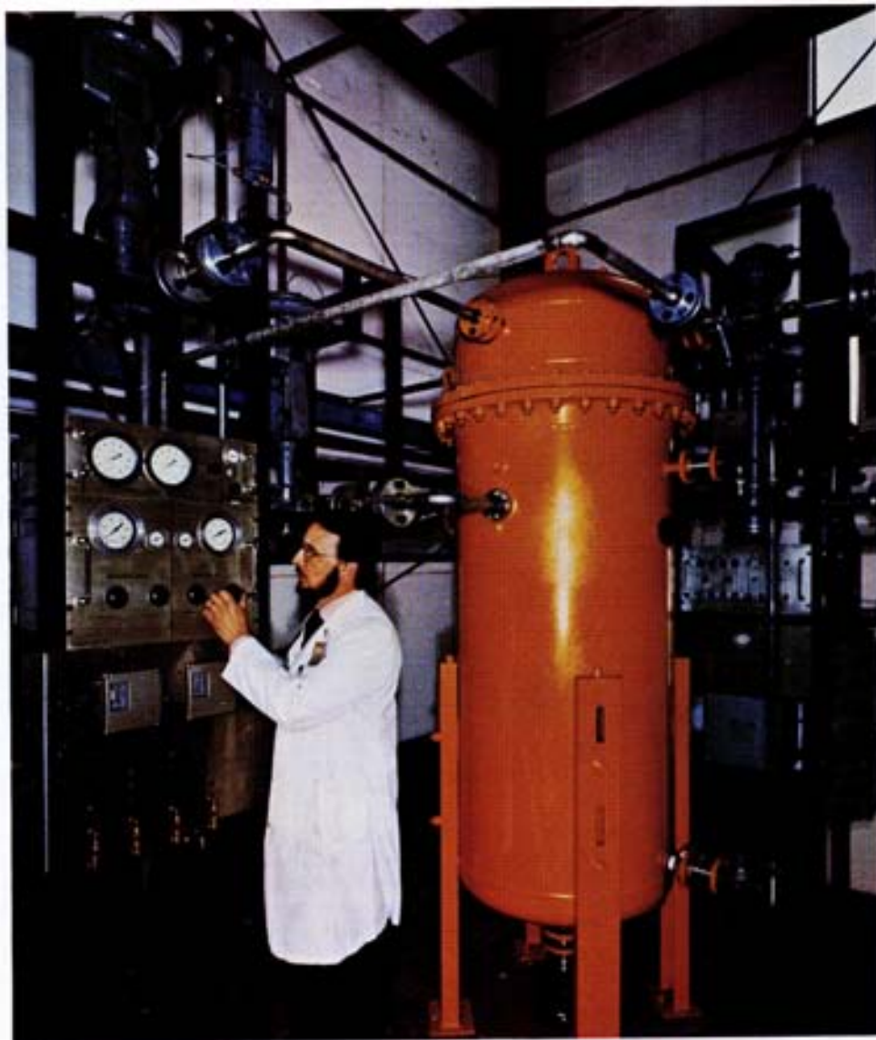
Fig. 26 - Impianto prototipo Barre Bifase per la regolazione fine della potenza neutronica di un reattore tipo CIRENE, realizzato per esperienze di controllo sul reattore RB-3 del CNEN di Montecuccolino (Bologna). La regolazione avviene attraverso la variazione di densità di una miscela bifase (acqua borata-gas), che scorre entro una tubazione inserita nel nocciolo (barra di controllo). Nella foto sono visibili il serbatoio a bassa pressione, le valvole di comando delle portate di liquido alle barre ed i sistemi di regolazione dell'impianto.
