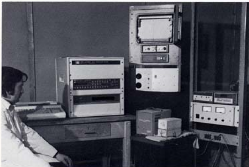
Fig. 133 - Sistema di acquisizione dati Hewlett Packard, utilizzato per misure di conducibilità e diffusività termica e per la taratura di sensori di temperatura. Esso è situato in una stanza a temperatura e umidità controllata per garantire condizioni uniformi e costanti di misura.
