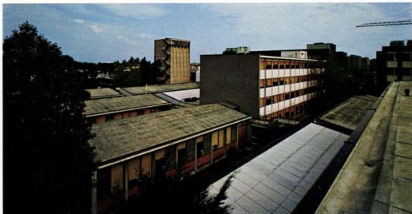
Veduta parziale del complesso edilizio del CISE dal tetto del fabbricato centrale (nello sfondo, la torre dell'acceleratore tandem Van de Graaff).
