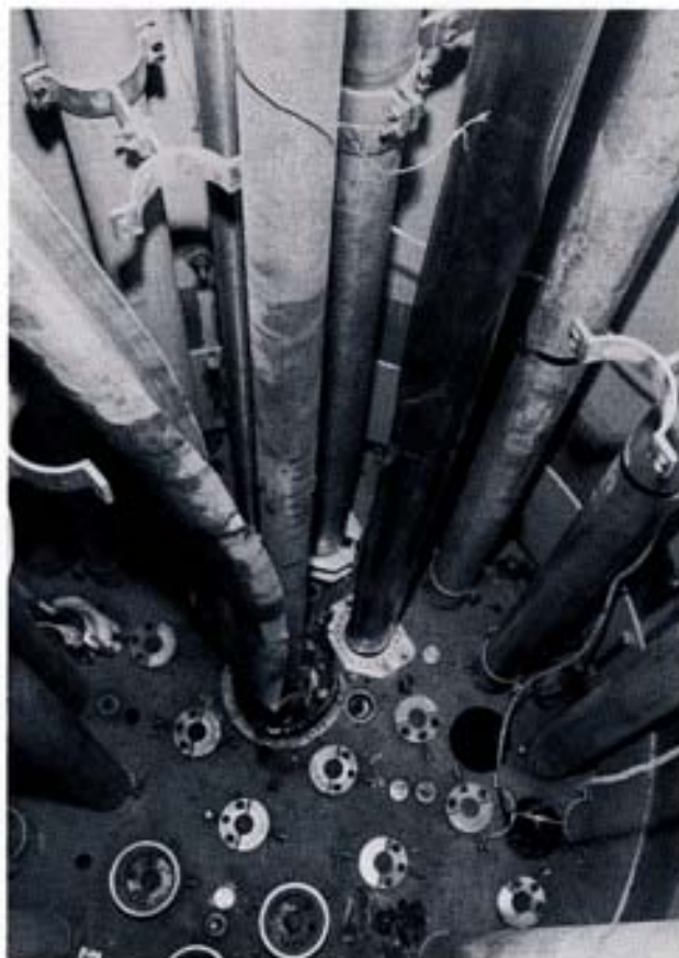
Fig. 28 - Interno del recipiente a pressione dell'impianto BETULLA (v. fig. precedente) dopo una prova di scoppio: sono visibili la piastra inferiore del recipiente, gli elementi passivi del reticolo e - al centro - l'elemento di scoppio (nei suoi due componenti: tubo interno strumentato e tubo esterno, apertosi in conseguenza dello scoppio) con immediatamente affacciato un canale di potenza CIRENE completo di tubo di calandria e tubo a pressione. Si può notare come, in conseguenza dello scoppio, il tubo di calandria risulti collassato sul tubo a pressione ad esso interno, che peraltro è rimasto integro.
