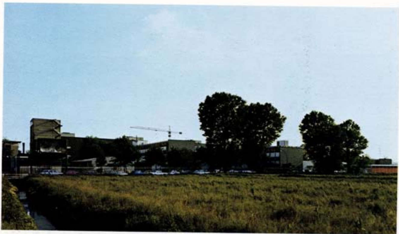
Veduta parziale del complesso edilizio del CISE (dal lato nord-est).
